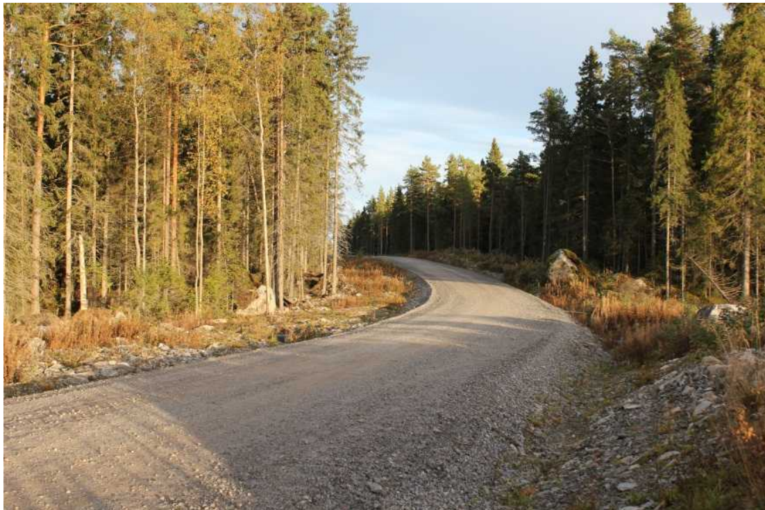
Kuva 3-8. Tuulivoimalan huoltotie – Öjen, Vaasa (Ramboll Finland Oy).
